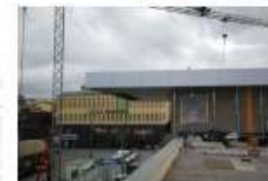
Montaggio dei rivestimenti
