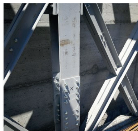
Particolari connessioni tra pilastri
