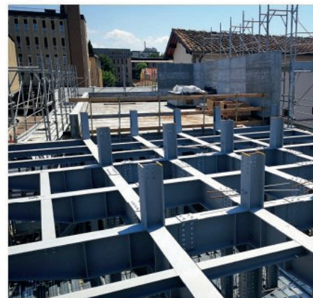
Particolare posa in opera pensilina
